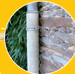
descente eaux pluviales/ eaux usées
