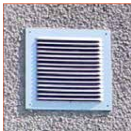
Exemple de grille d'entrée ou de sortie d'air en façade
