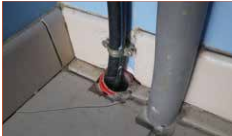
Exemple de défauts d'étanchéité
