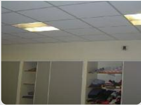
Photo 13 : Bouches d'extraction d'air dans un dortoir
