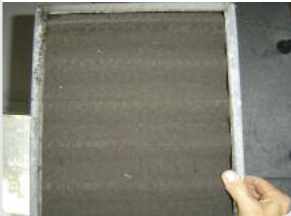
Photo 15 : Filtre de CTA très encrassé
