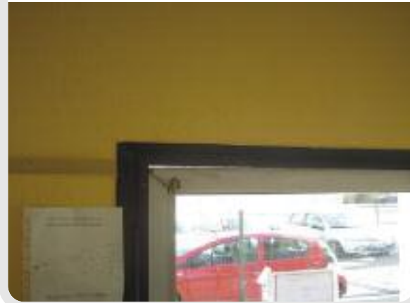
Photo 14 : Porte-fenêtre non étanche à l'air (jour visible)
