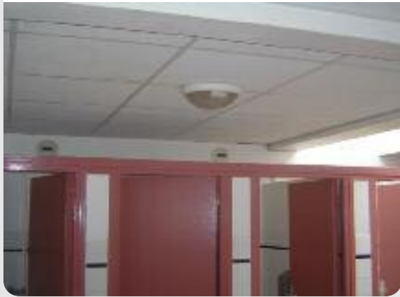
Photo 11 : Bouches d'extraction dans des sanitaires
