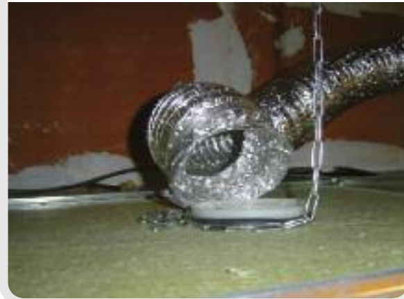
Photo 12 : Bouche déconnectée au-dessus du plafond
