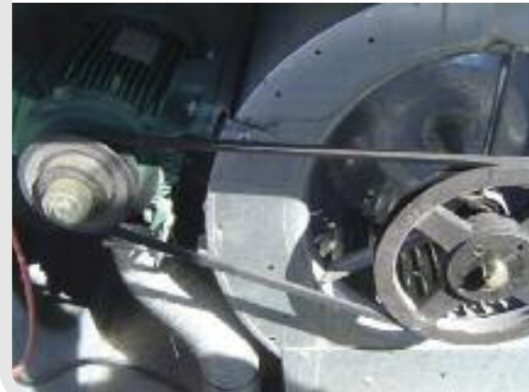
Photo 2 : Courroie ventilateur en bon état
